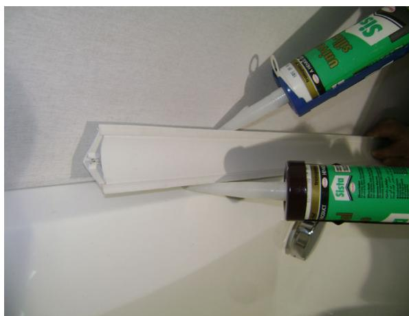
3- Kenar profilini silikonlanmış köşeye yerleştiriniz. Duvarda ve küvet yüzeyinde boşluğ kalmayacak şekilde bastırınız.
